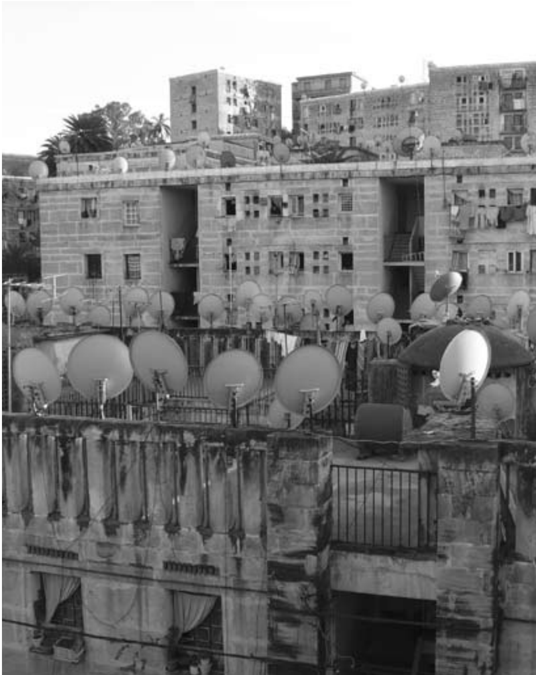
Dizaines de paraboles dans un quartier à Alger.
